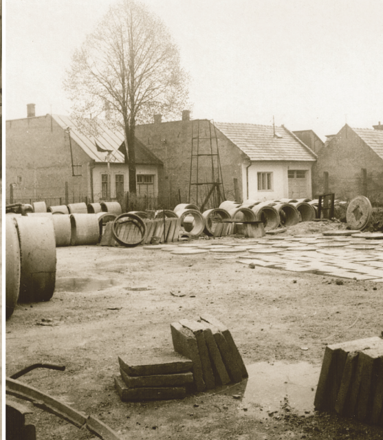
Betonárska výroba na Hollého ulici, rok 1966
